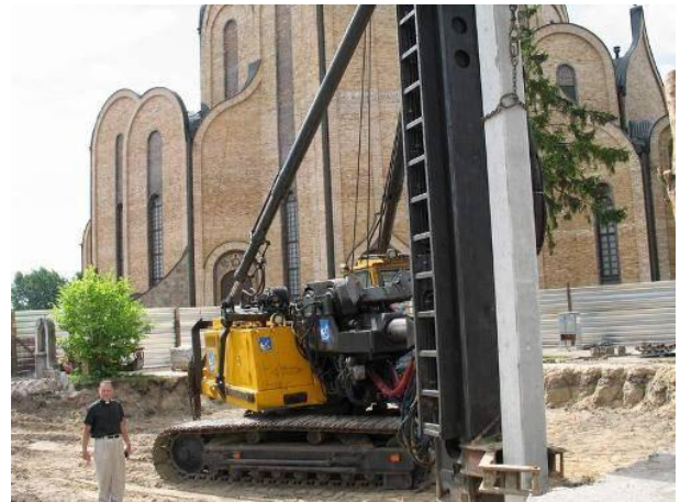
Fot. 6. Wykonanie fundamentu palowego dzwonnicy – Białystok
