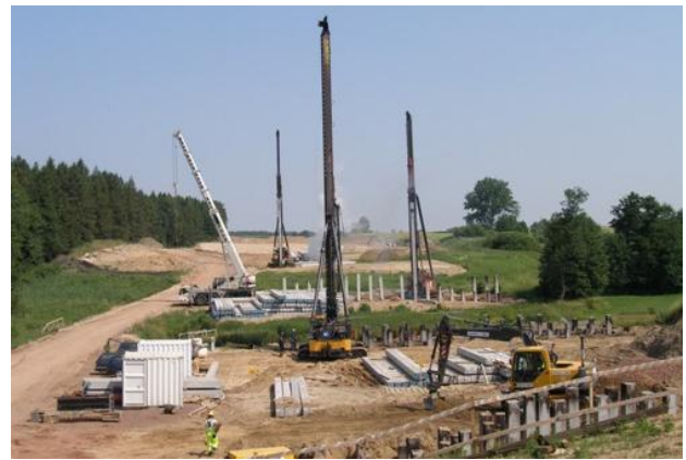
Fot. 8. Wykonanie fundamentów palowych obiektów mostowych – Autostrada A1
