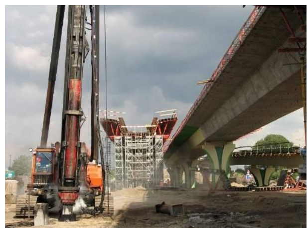
Fot. 10. Obiekty i palowanie fundamentu estakady w węźle Marsa
