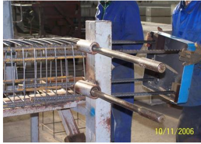
Montaż złączki
