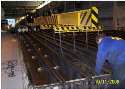
Układanie zbrojenia
