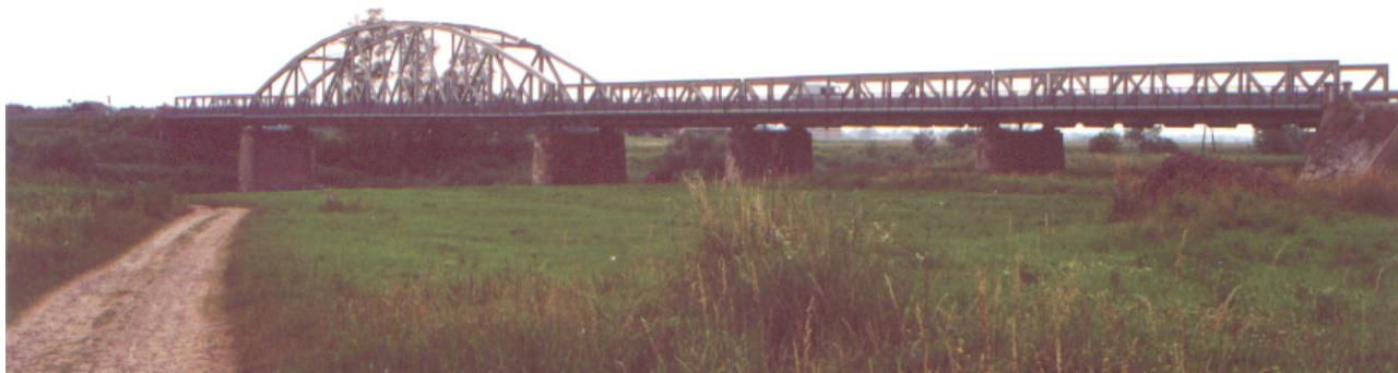
Fot. 3. Stary most przez San w Radymnie w ciągu obecnej DK 4
