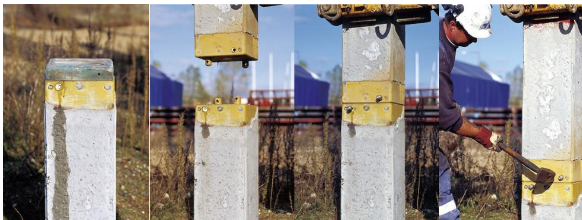
Fot. 15. Kolejność czynności przy łączeniu pala złączką mechaniczną (od lewej: wbicie dolnego odcinka pala z użyciem podkładki zabezpieczającej, osadzenie na złączu górnego odcinka pala, wbicie bolców blokujących i kontynuowanie wbijania pala)
