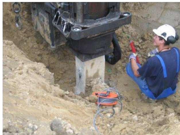
Fot. 19. Montaż czujników do badania dynamicznego nośności pala
