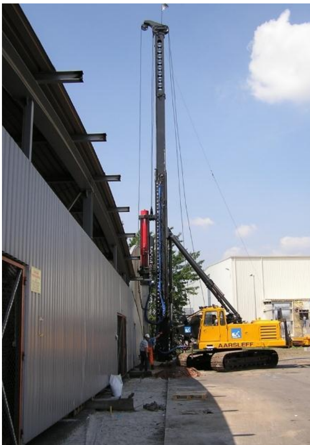
Fot. 13. Fundamenty hali przemysłowej AluPol w Tychach wykonywany tuż przy istniejącej hali
