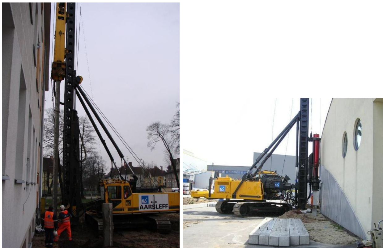
Fot. 16. Przykłady wbijania pali przy istniejących budynkach
