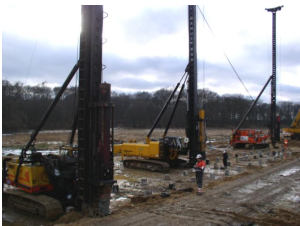
Fot. 9. Wzmocnienie podłoża pod nasypem - Autostrada A-2 pod Nowym Tomysłem
