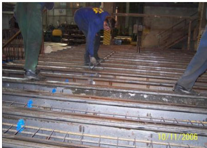
Montaż haków transportowych
