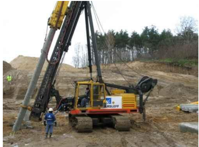
Fot. 12. Wiadukt nad koleją w ciągu obwodnicy Wyszkowa
