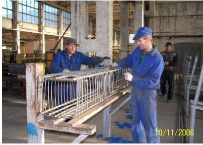
Przygotowanie zbrojenia
