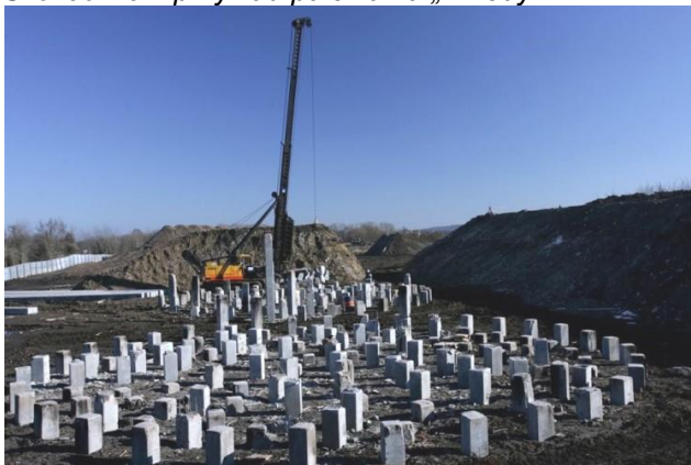
Fot. 7. Fundament palowy zbiornika oczyszczalni ścieków „Pomorzan” – Szczecin
