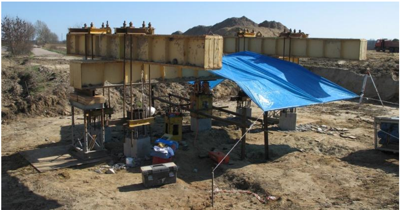
Fot. 17. Typowe stanowisko do badania nośności pali pod próbnym obciążeniem statycznym metodą belki odwróconej
