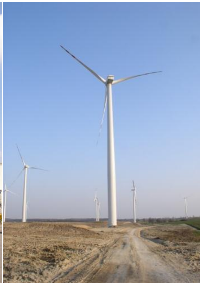
Fot. 14. Turbiny farmy wiatrowej w Kisielicach posadowione na palach prefabrykowanych
