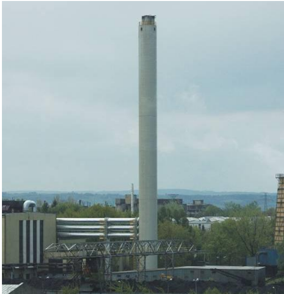
Fot. 11. 80-cio metrowy komin posadowiony na palach prefabrykowanych – teren WSK Rzeszów
